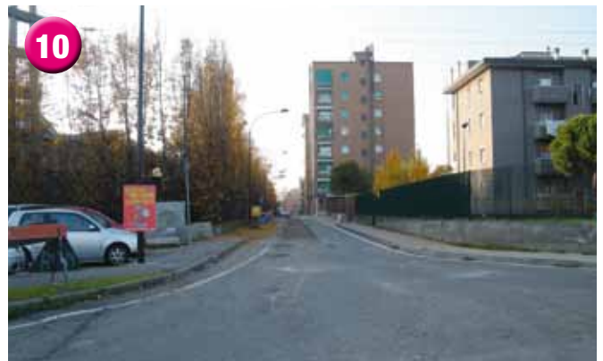
▲ In via Guerrazzi a Villaggio Giovi, è avvenuta l'intera sostituzione della rete fognaria. Un intervento di 45 mila euro.
