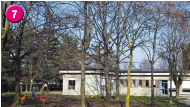
▲ Sono stati bonificati dall'amianto tre tetti delle scuole materne Madre Teresa di Calcutta di via Roma (costo 110mila euro), Arco baleno di via Pace (167 mila euro) e la scuola media Antonio Gramsci di via Puccini (87520 mila euro) i soldi per questi lavori arrivano dal risarcimento dell'ex Acna e fanno parte di quei progetti pensati per la salvaguardia dell'ambiente.
